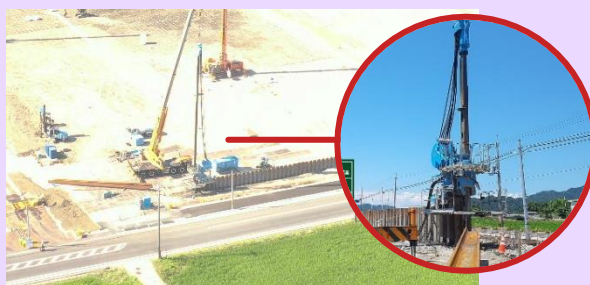
▲鋼矢板打設状況
