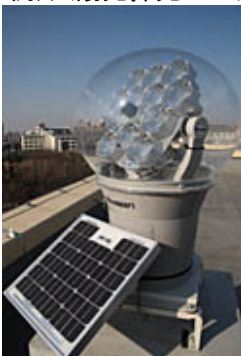
例)太陽光採光システム
