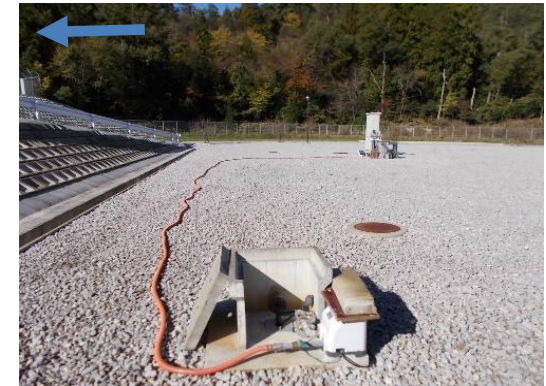
最終処分場下流のモニタリング井戸
