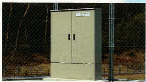
漏水検知システム
