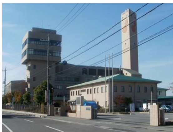
クリスタルプラザ（焼却・リサイクル施設）
