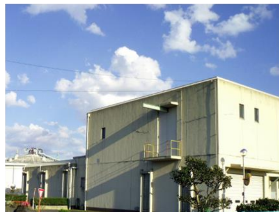
第1プラント（し尿処理施設）
