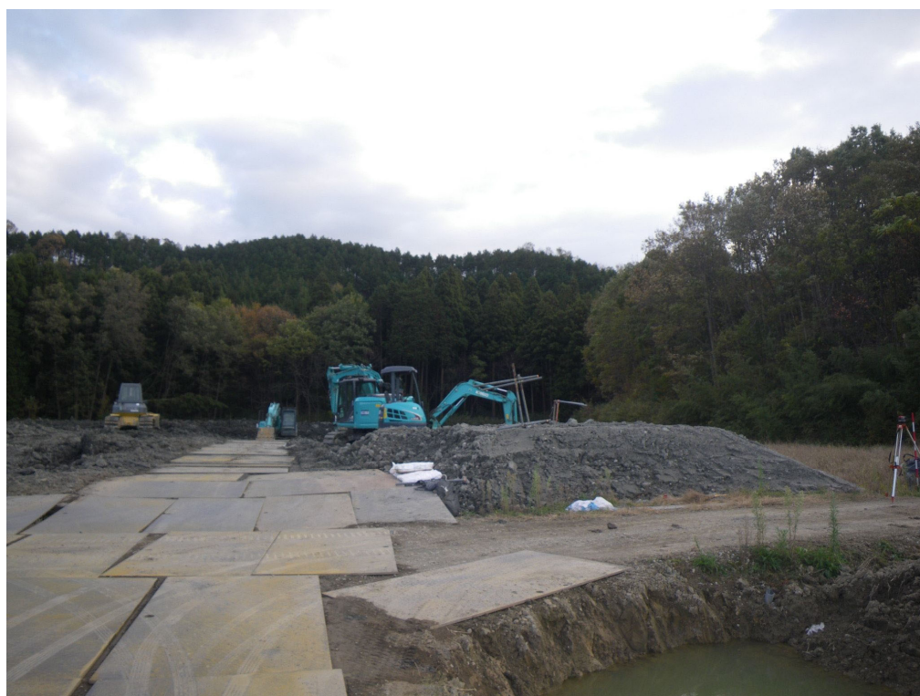
図 10.4-5 建設発生土の受入れ状況(2018.11.19)
