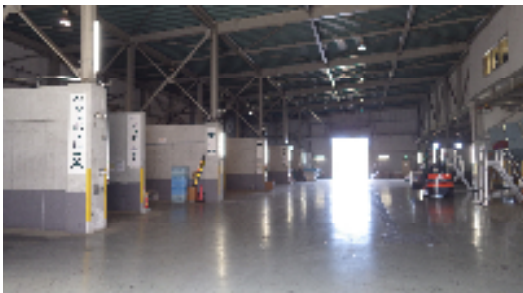
⑤資源ごみ貯留場
