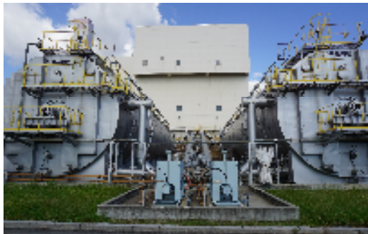
⑦メタン発酵槽
