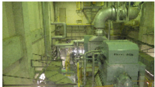
⑥蒸気タービン発電機
