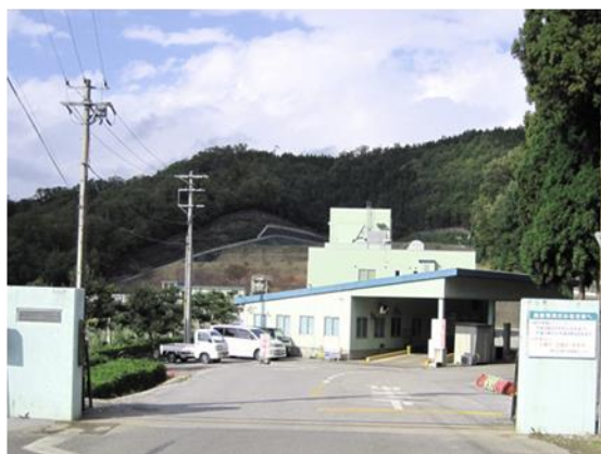
クリーンプラント（粗大ごみ処理施設）
