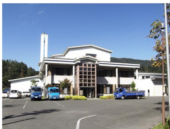
伊香クリーンプラザ（焼却施設※現在廃止）
