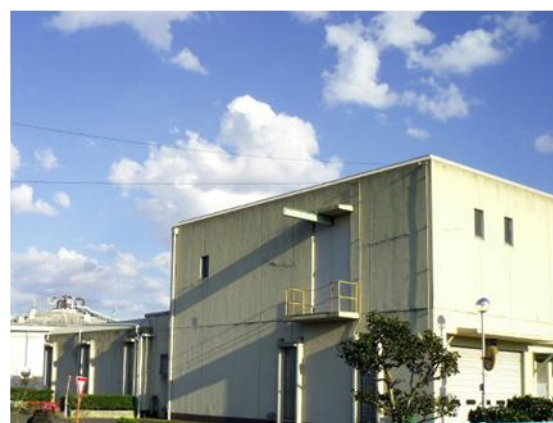
第1プラント（し尿処理施設）
