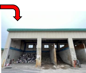
ストックヤード(クリスタルプラザ内)
